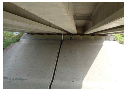
▲ 교량받침 점검로 근접조사
