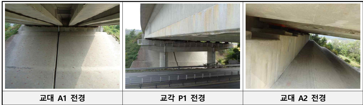
[교대 및 교각 전경]
